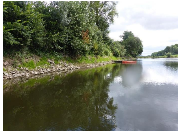
Figure 218 : Aperçu des berges enrochées (rive droite)
