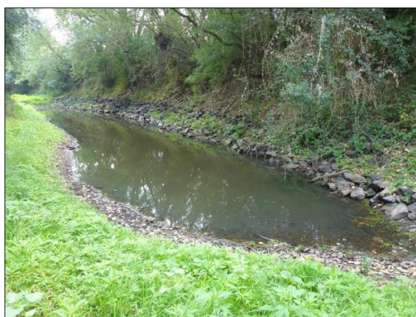
Figure 290 : Aperçu général du site (vue vers l'amont).
