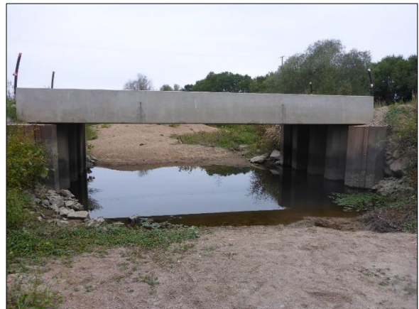
Figure 87 : Pont en extrémité aval du site
