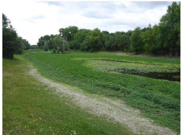
Figure 303 : Extrémité aval du site.
