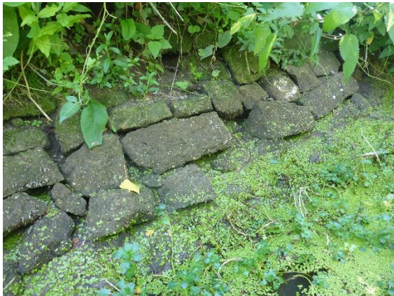
Figure 349 : Berge rive gauche enrochée/pavée.
