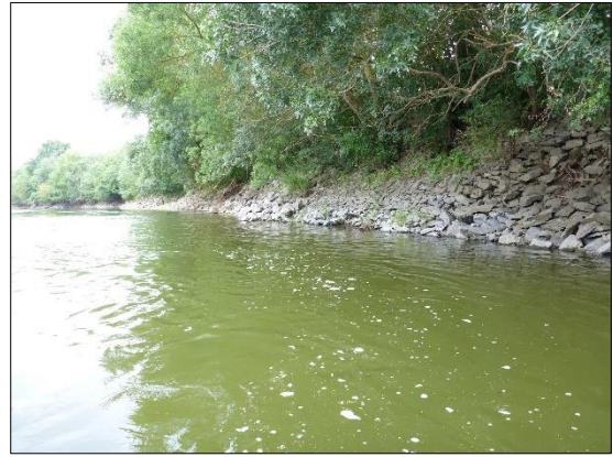
Figure 322 : Berges protégées par enrochements.
