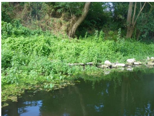
Figure 454 : Rive sud. Blocs de protection du talus (développement de menthe aquatique, nénuphars, jussie...).
