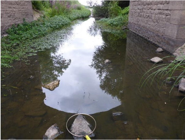
Figure 240 : Extrémité aval du site (sous le pont)
