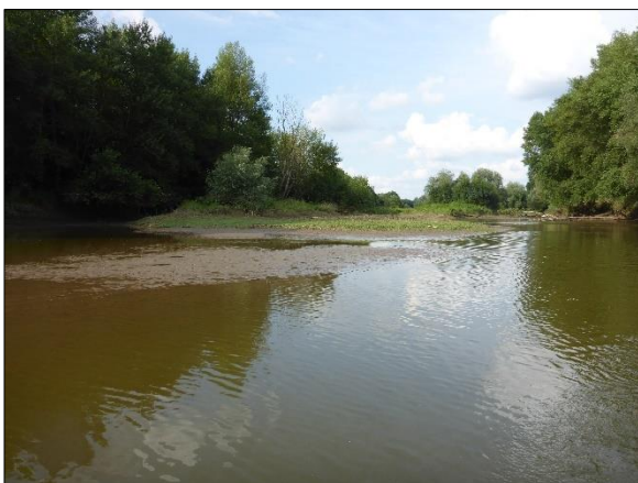
Figure 94 : Vue vers l'amont du site (04/07/2018).
