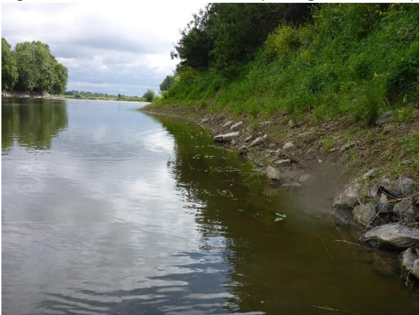
Figure 219 : Aperçu des berges enrochées (rive gauche)
