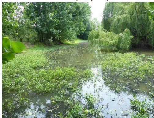
Figure 421 : Vue vers l'amont / Prise de vue depuis la digue.
