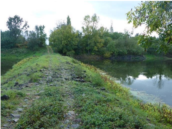
Figure 217 : Extrémité aval du site (ouvrage transversal).
