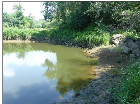
Figure 131 : Aperçu de la partie 1 (01/07/2019) / Point d'exutoire de la digue à droite.
