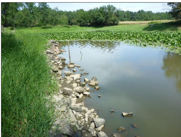
Figure 128 : Aperçu de la partie 2 : cordon d'enrochements en berge (01/07/2019).
