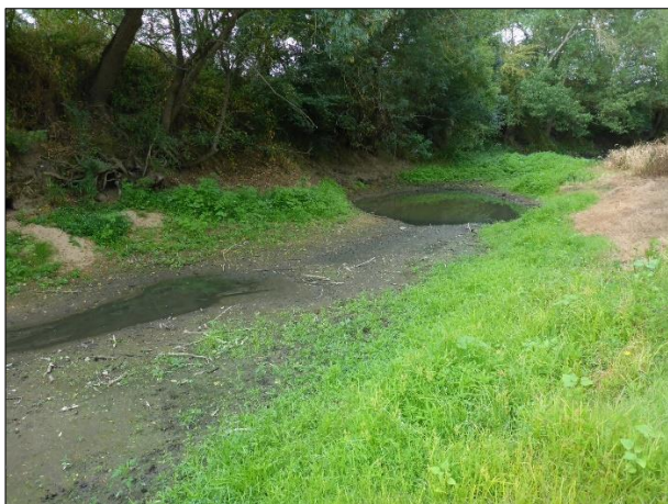
Figure 287 : Aperçu général du site (vue vers l'aval).
