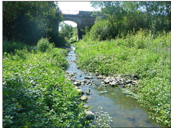
Figure 237 : Aperçu de la partie 1 (02/07/2019) / Vu vers l'aval
