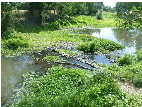
Figure 256 : Radier en partie aval du site.
