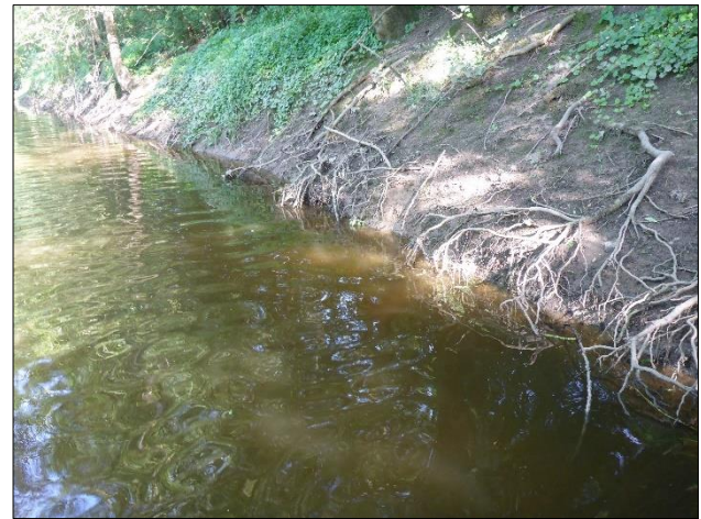
Figure 161 : Berge au tracé rectiligne et au profil régulier peu biogène. Les petits systèmes racinaires assurent un minimum d'habitats structurants/support à la faune aquatique.
