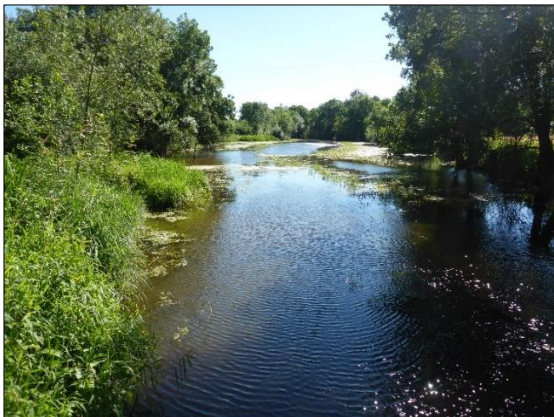
Figure 156 : Prise de vue depuis le vannage vers l'amont du site (21/06/2018).
