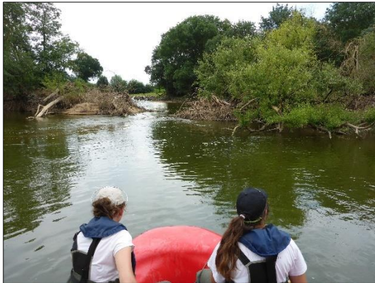
Figure 323 : Aperçu du site n°1 / îlot végétalisé où s'est amassé de nombreuses encombrés (03/07/2018)
