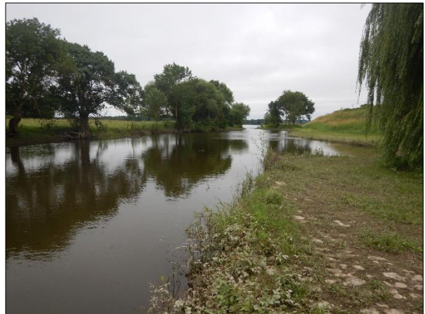
Figure 392 : Aperçu général de la boire du Rateau (21/06/2018 → débit de la Loire à Saumur : 650 m 3 /s).
