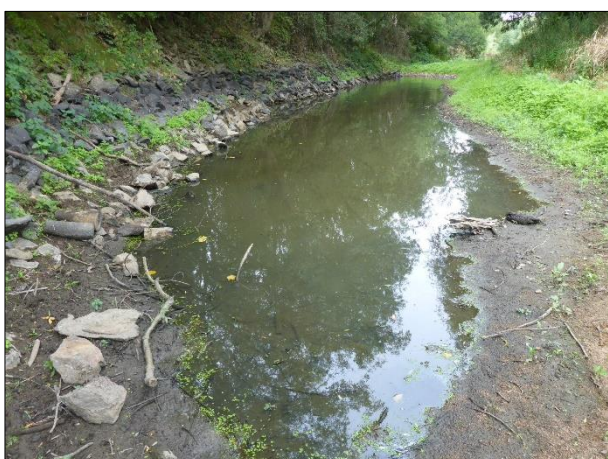
Figure 289 : Aperçu général du site (vue vers l'aval).
