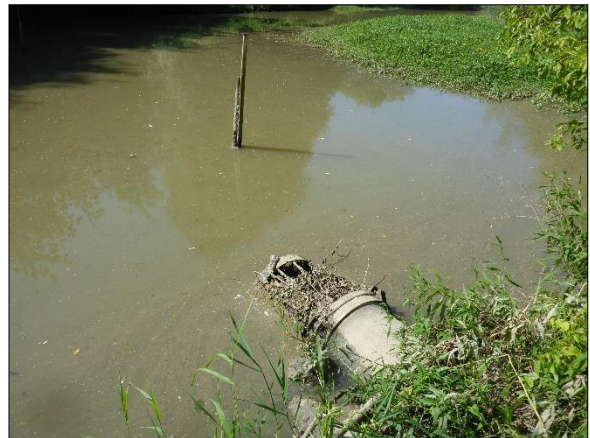
Figure 48 : Connection busée de la boire avec la Loire.
