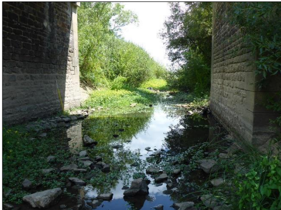
Figure 246 : Extrémité aval du site (sous le pont)
