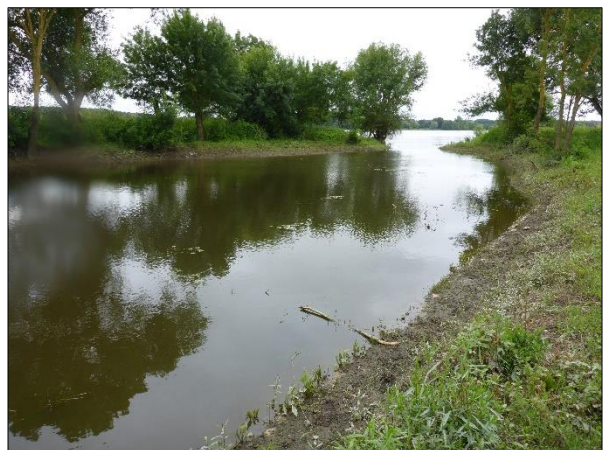
Figure 394 : Aperçu général de la boire du Rateau (21/06/2018 → débit de la Loire à Saumur : 650 m 3 /s).
