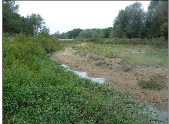
Figure 85 : Zone hors d'eau ensablée en amont du pont.
