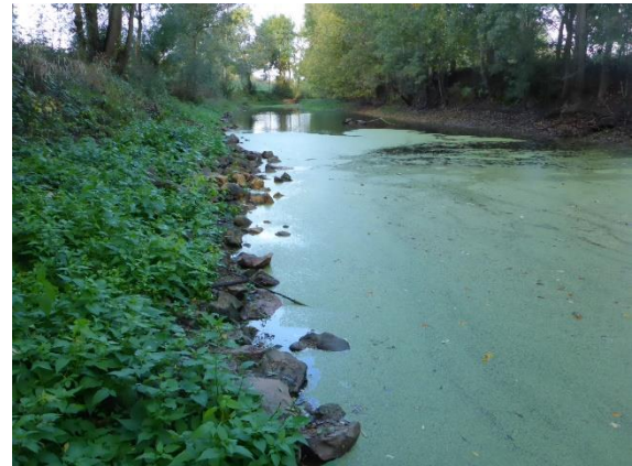
Figure 350 : Enrochement en pied de berge (rive gauche).
