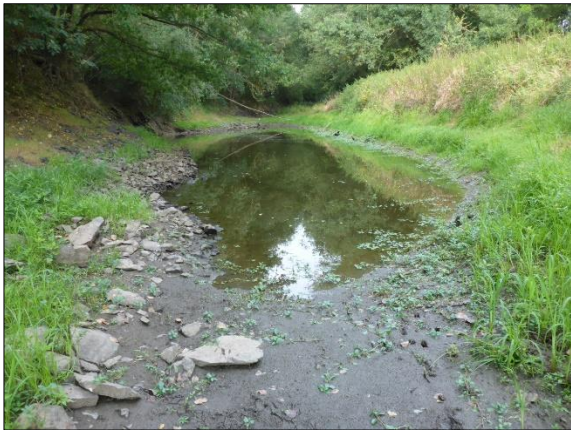
Figure 281 : Aperçu général du site (vue vers l'aval).
