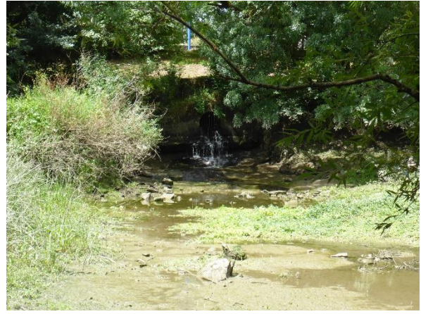
Figure 62 : Ressuyage d'un fossé latéral en amont du passage à gué.
