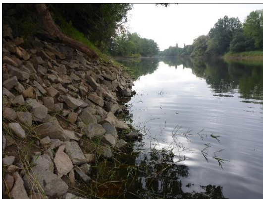
Figure 202 : Berge droite enrochée du site 2 de la boire de Vinette (04/07/2018) / Berge pentue et lit profond de plus de 2.0 mètres.
