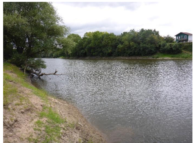
Figure 223 : Aperçu général du site (rive droite).
