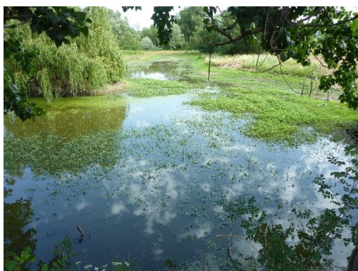
Figure 422 : Vue vers l'amont (03/07/2019) / Prise de vue depuis la digue.
