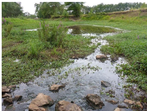
Figure 261 : Radier sur la partie aval du site.
