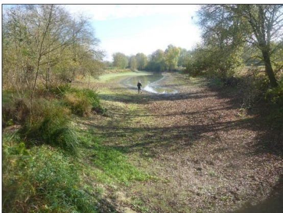
Figure 158 : Prise de vue depuis le vannage vers l'amont du site (17/10/2018).
