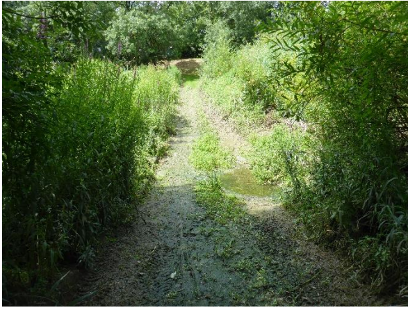
Figure 61 : Passage à gué contraignant la dynamique hydro-sédimentaire.
