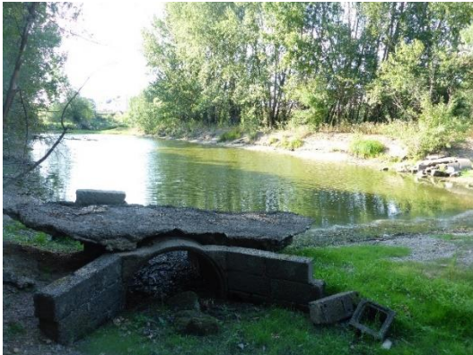
Figure 431 : Aperçu de la vasque n°2 depuis son extrémité amont. Au premier plan, ancien ouvrage de régulation hydrauliques des « plans d'eau ».
